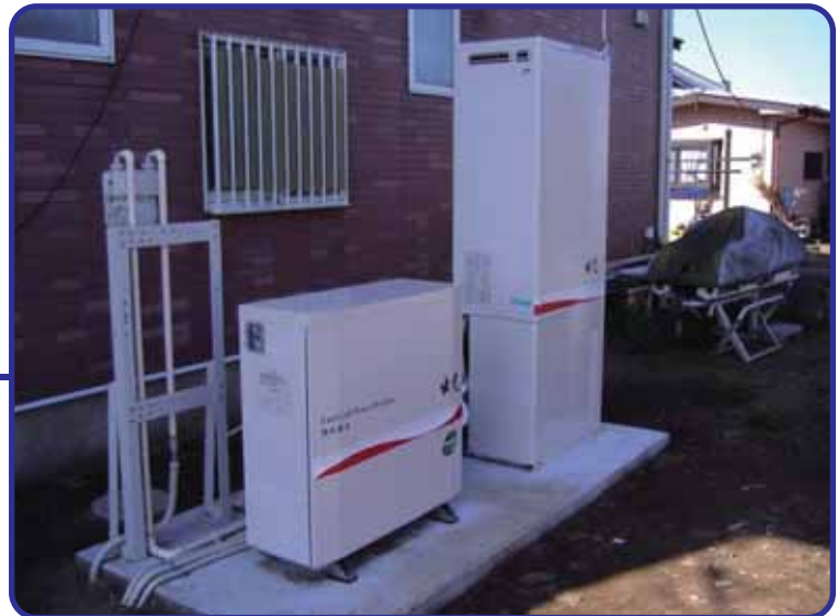
LPG 燃料 1kW 級 PEFC コージェネレーションシステム (出光興産)
