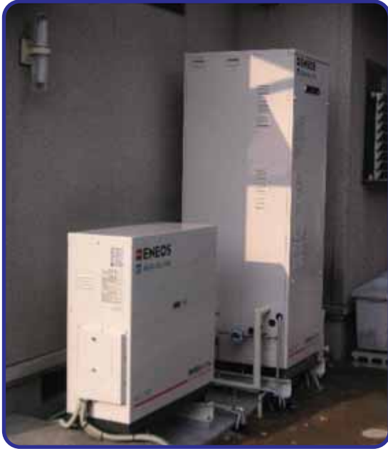
石油燃料 1kW 級 PEFC コージェネレーションシステム (新日本石油)
