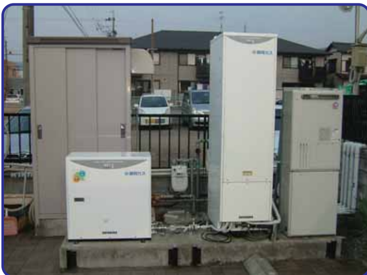
都市ガス燃料 1kW 級 PEFC コージェネレーションシステム (I H I シバウラ)
