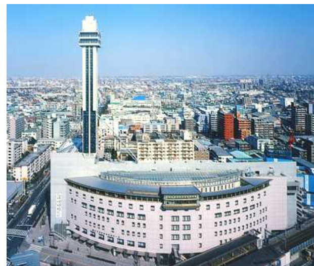
タワーホール船堀
