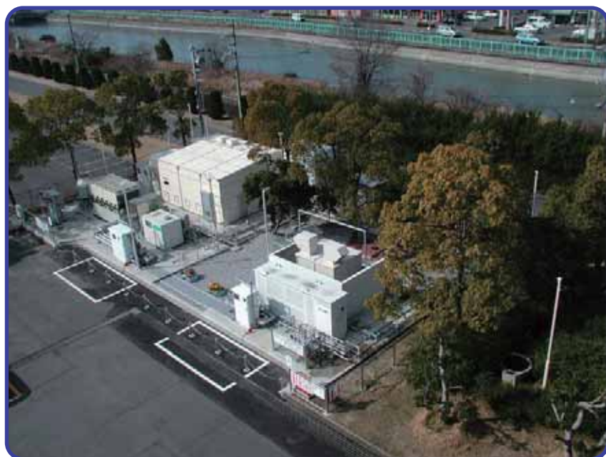
水素供給ステーション全景 (PEM電解型) (四国総合研究所)
