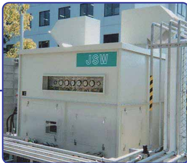
水素圧縮機ユニット (日本製鋼所)
